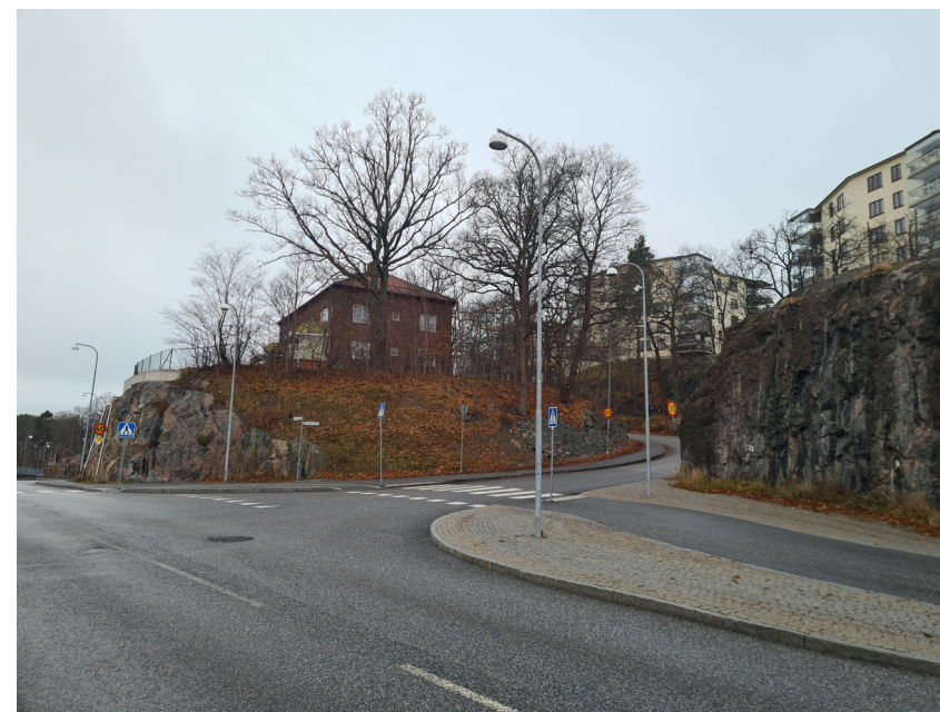
Foto som visar på Förmansbostadens utmärkande läge i topografin, bergsskärning mot Kvarnholmsvägen och glacis mot Finnbergsvägen.
