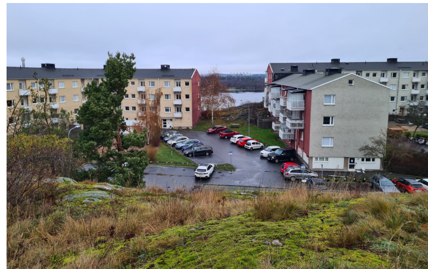
Bostadsområdet på Finnberget uppfördes på 1940 - talet för arbetarna på Finnboda varv. Bebyggelsen med långsmala lameller är luftigt placerade med anpassning till bergets former.
