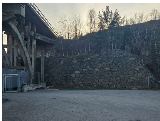
Vid Kvarnholmsbrons södra brofäste finns delar av den tidigare serpentinvägens naturstensmurar kvar.
