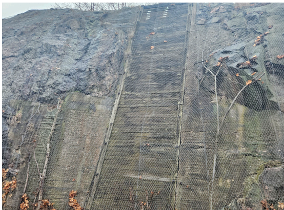
I berget i anslutning till de kvarvarande industribyggnaderna finns rester efter tidigare industriella epoker.
