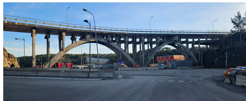
Kvarnholmsbron uppfördes 1924 och tillhör den första generationens betongbroar. Bron är unik genom sin dragning i en kurva.
