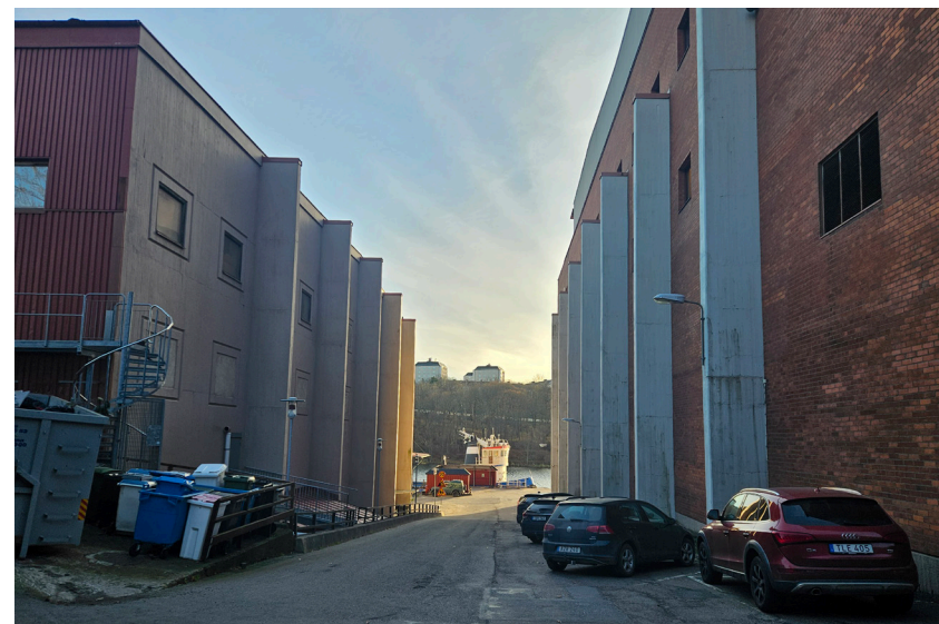
Passage mellan de före detta industribyggnaderna ner mot kajen och Svindersviken. Korningsfabriken till vänster och Kafferosteriet till höger med den synliga betongstommen som delvis bevaras i den föreslagna omvandlingen.
