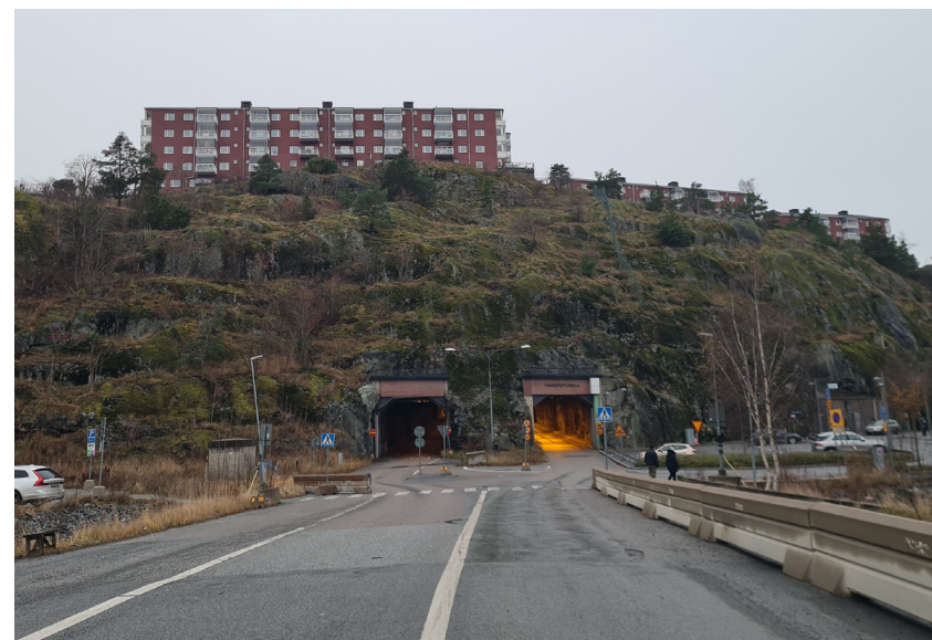
I samband med att Hästholmssundet lades igen i början av 1970-talet anlades Finnbergstunneln för att underlätta transporterna mellan industrierna. Vy från sundet mot Finnberget.
