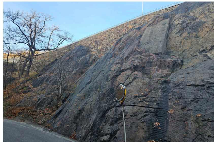
Industrivägen slingrar sig ner mot kajen förbi en delvis bearbetad bergsformation som kröns av Kvarnholmsvägens naturstensmurade vägbank. Berget bedöms som karaktärgivande i tidigare kulturmiljöanalys.
