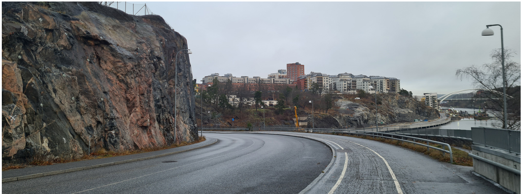
Vy längs med Kvarnholmsvägen i kurvan ner mot Kvarnholmsbron. Till vänster syns de vertikala bergsskärningar som utfördes vid breddningen för cykelbanan på 2010-talet. Bebyggelseförslaget innebär ytterligare ingrepp i berget och att det till stora delar skymms av ny bebyggelse. Vägen blir delvis bebyggd och omvandlas till en återvändsgata.
