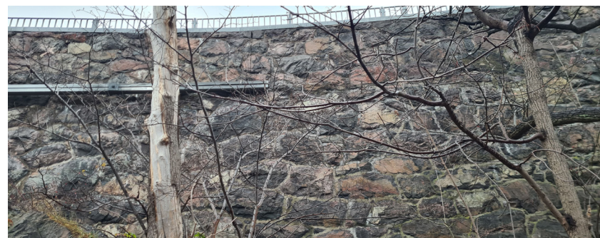
Stödmur längs Kvarnholmsvägen, bakom vakthuset.
