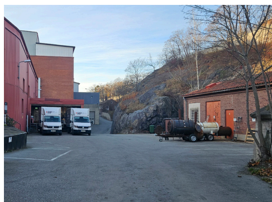
Transformatorstationen till höger som uppfördes med Korningsfabriken i början av 1950-talet.
