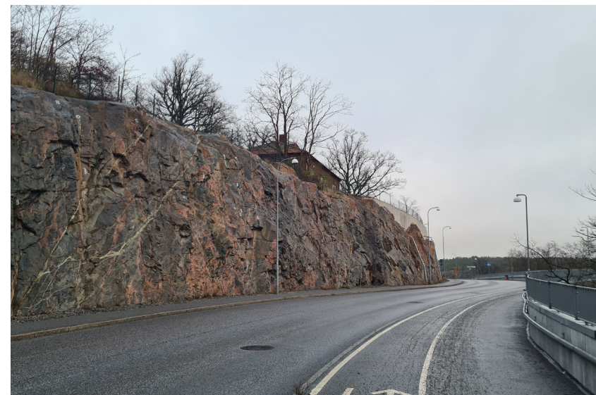
Foto som visar den bergkantade Kvarnholmsvägen norrut mot Förmansbostaden där det nya punkthuset ska ansluta mot vägen.
