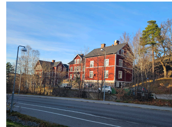
Västerut längs Kvarnholmsvägen, utanför de aktuella planområdena, ligger ännu de tidigaste arbetarbostäderna från början av 1900-talet.
