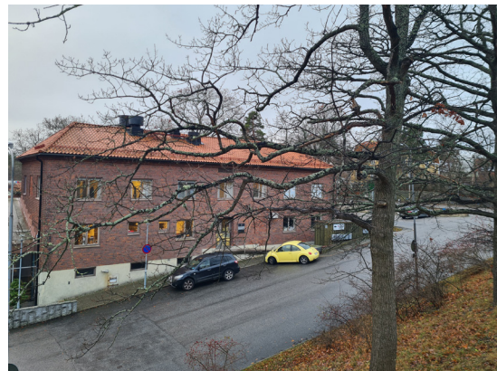
Kontoret invid det fd Kafferosteriet ansluter till den interna industrivägen som löper ner till kajen vid fd Korningsfabriken.
