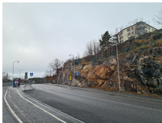
Berget intill Kvarnholmsvägen har bearbetats i omgångar. Här syns sträckan mellan Förmansbostaden och Kvarnholmsbron.
