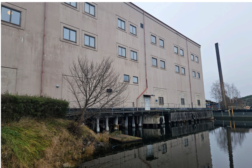
Den före detta Korningsfabriken med till stor del oförändrad exteriör kragar ut över vattnet med pålad grundläggning.
