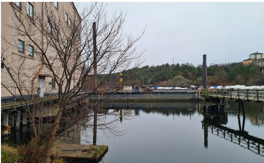
Den tidigare Korningsfabriken är delvis placerad på pålar i vattnet.
