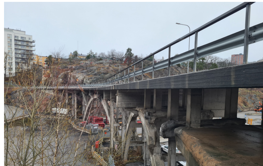
Bron över Hästhalmssundet har genomgått en rad ombyggnader. I förgrunden syns nivån för den äldre vägbanan som höjdes till nuvarande nivå 1985.
