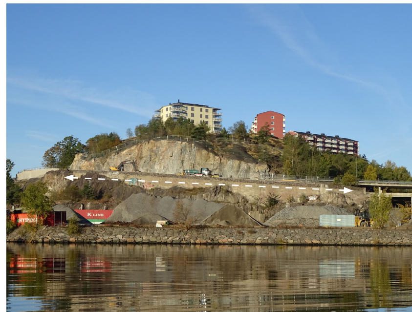
Kvarnholmsvägen från vattnet. Berget har byggts på med massor som hålls på plats med naturstensmurade vägbankar för att skapa en plan vägbanan. Någon gång har naturstenen fått en överstrykning med betong. Den vita pilen visar den sträcka av muren som försvinner med byggandet av nya Kvarnholmsvägen
