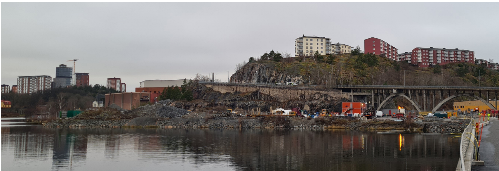
Kvarnholmsvägens sträckning, vid Finnbergets fot. På bilden syns tydligt murarna längs med vägbankarna och hur fyllning för vägen har lagts ovanpå berget för att skapa en plan körbana. Notera det ursprungliga läget för bronns nedre körbana som syns vid brofästet.
