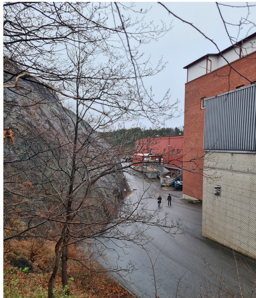
De oregelbundna bergsbranterna ansluter direkt till den lokala industrigatan bakom de båda tidigare fabriksbyggnaderna.
