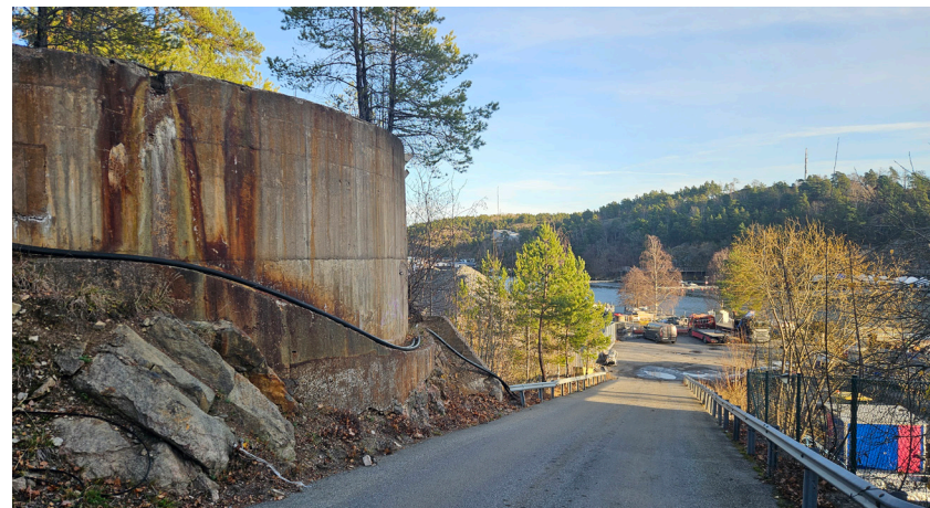
Resterna efter Oljekompaniets oljecisterner ligger inpassade i bergets sluttning ner mot kajen.
